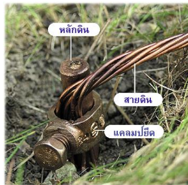
(ข) การต่อสายดิน
